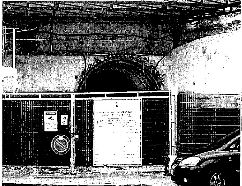
LAVORI IN CORSO/2 Ancora al palo l'ascensore che dovrebbe collegare Santa Lucia con Monte Echia
