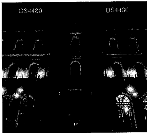
Palazzo della Borsa Fu edificato tra il 1895 e il 1899
